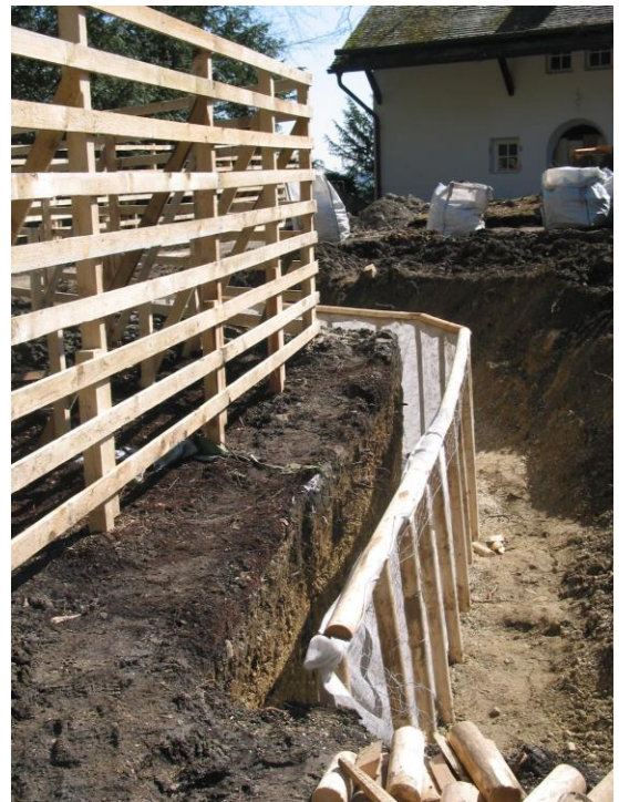
Abbildung 2: Baumschutzzaun und Wurzelschutzzaun – fachgerechter Wurzelschnitt - vor der Hinterfüllung mit humusreichem Substrat
