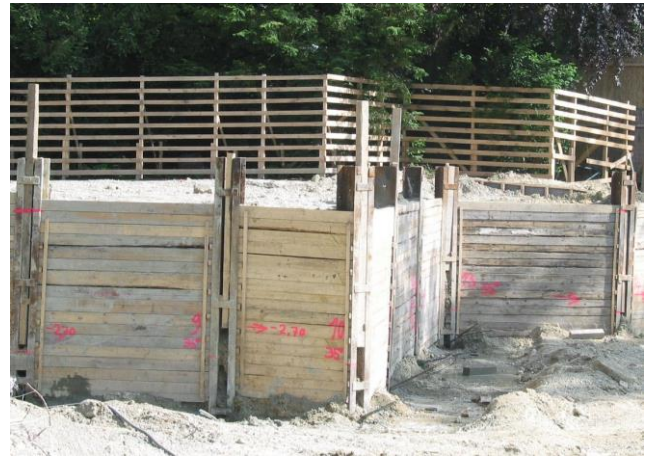
Abbildung 3: Berliner Verbau und Baumschutzzaun
